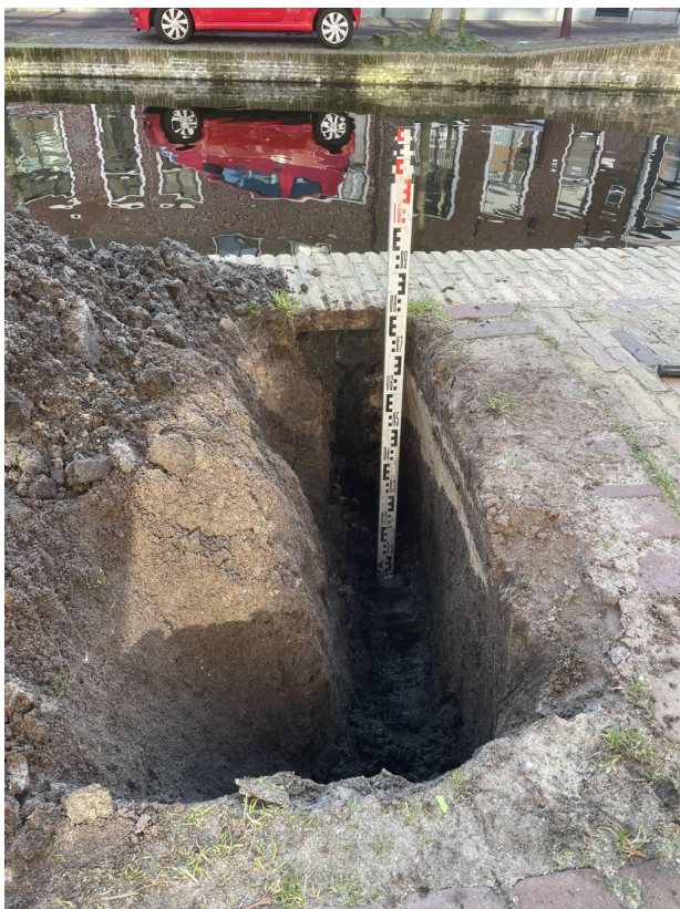
Figuur 3.24 Profielsleuf ter hoogte van Geerweg 51 tussen kademuur en rijbaan in een boomspiegel
