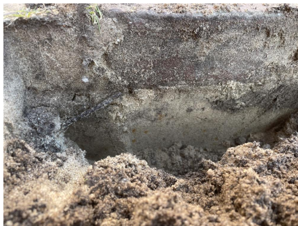
Figuur 3.25 Oxidatievlekken in het straatzand direct onder de klinkers van de rijbaan
