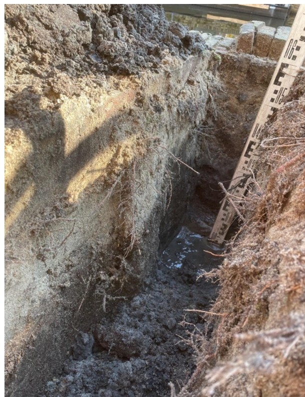
Figuur 3.21 Profielsleuf ter hoogte van Molstraat 104 tussen kademuur en rijbaan
