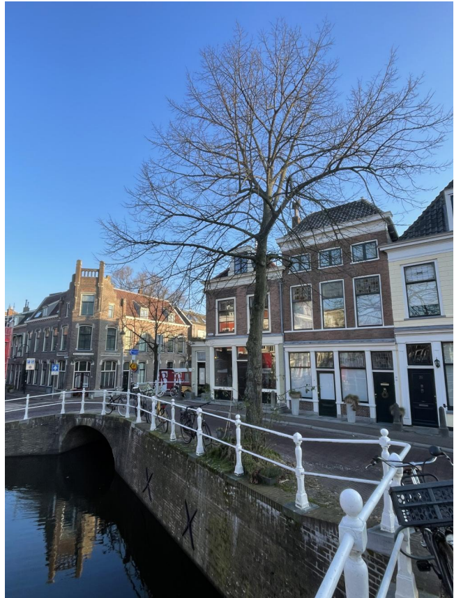
Figuur 1.1 Voorbeeld van een goed functionerende jong-volwassen linde aan een hoge kademuur (brughoofd, Kolk 28-30)
