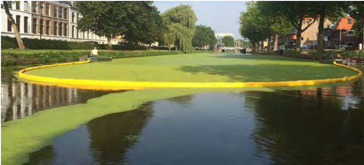
Figuur 6: kroos verzamelen op het Rijn-schiekanaal met een oliescherm tussen twee boten
