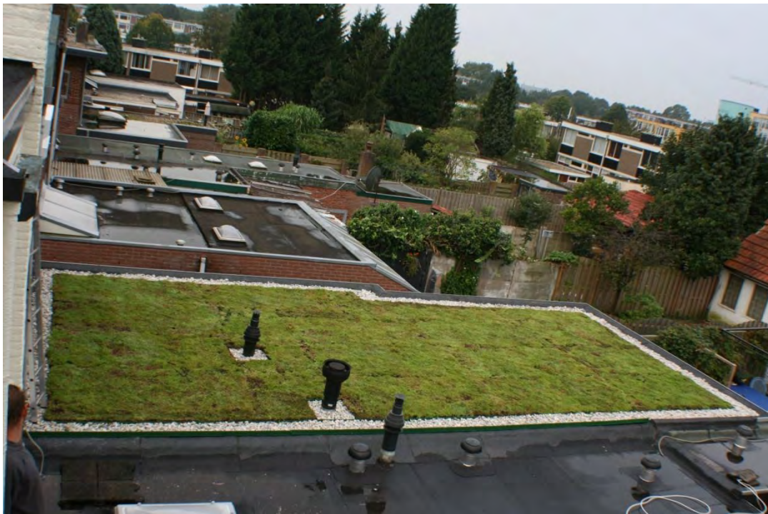
Figuur 46 Groen dak bij een particulier in Nijmegen. ( riekengroenedaken.nl )
