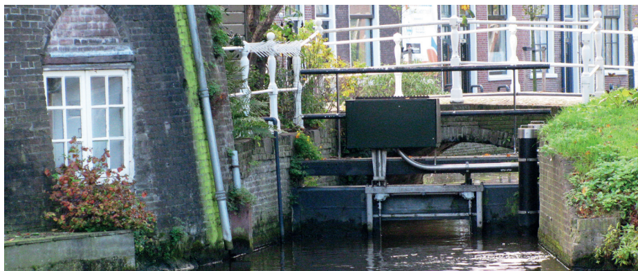
Sluisjes maken het mogelijk de binnenstad los te koppelen van het boezempeil
