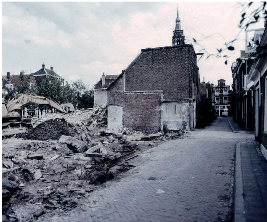
Cellebroerstraat met sloop Dertienhuizen 1981, Rijksdienst voor het Cultureel Erfgoed
