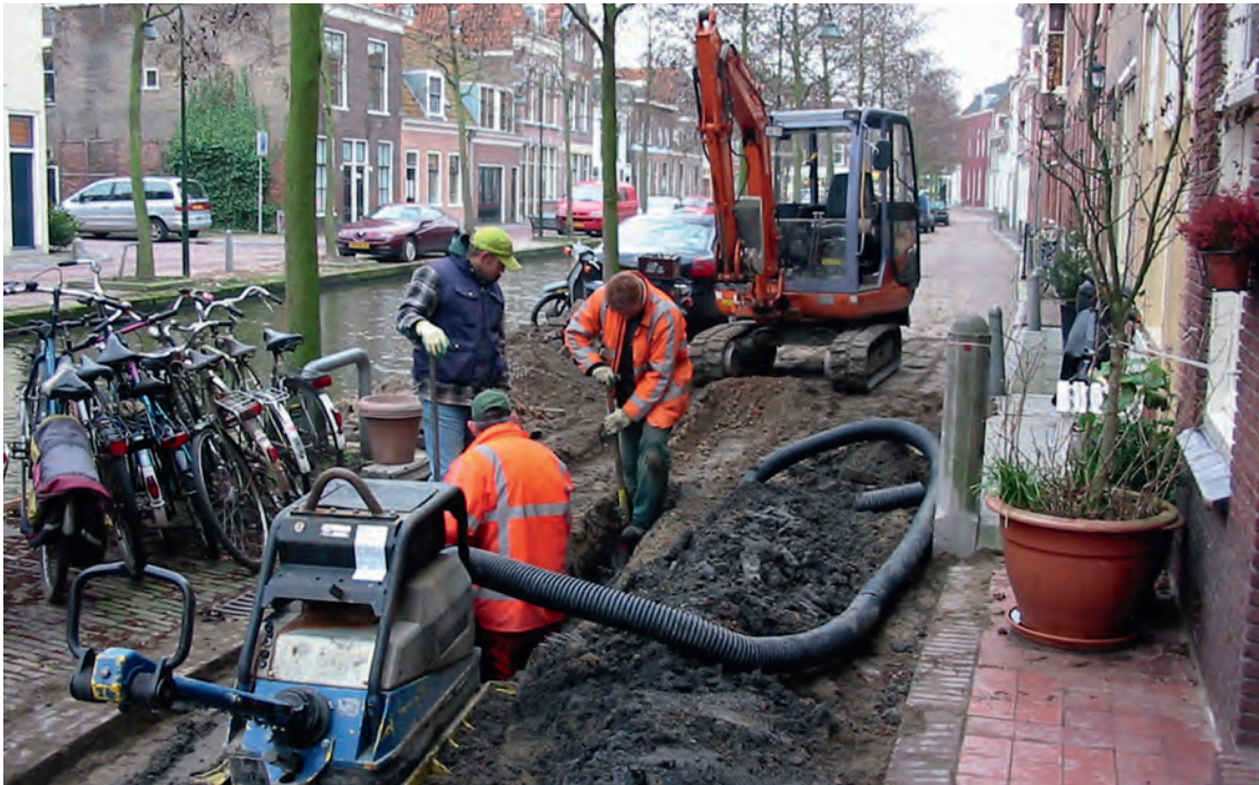
Aanleg van drainage in de Delftse binnenstad. FOTO: RENÉ VAN DER WERF
